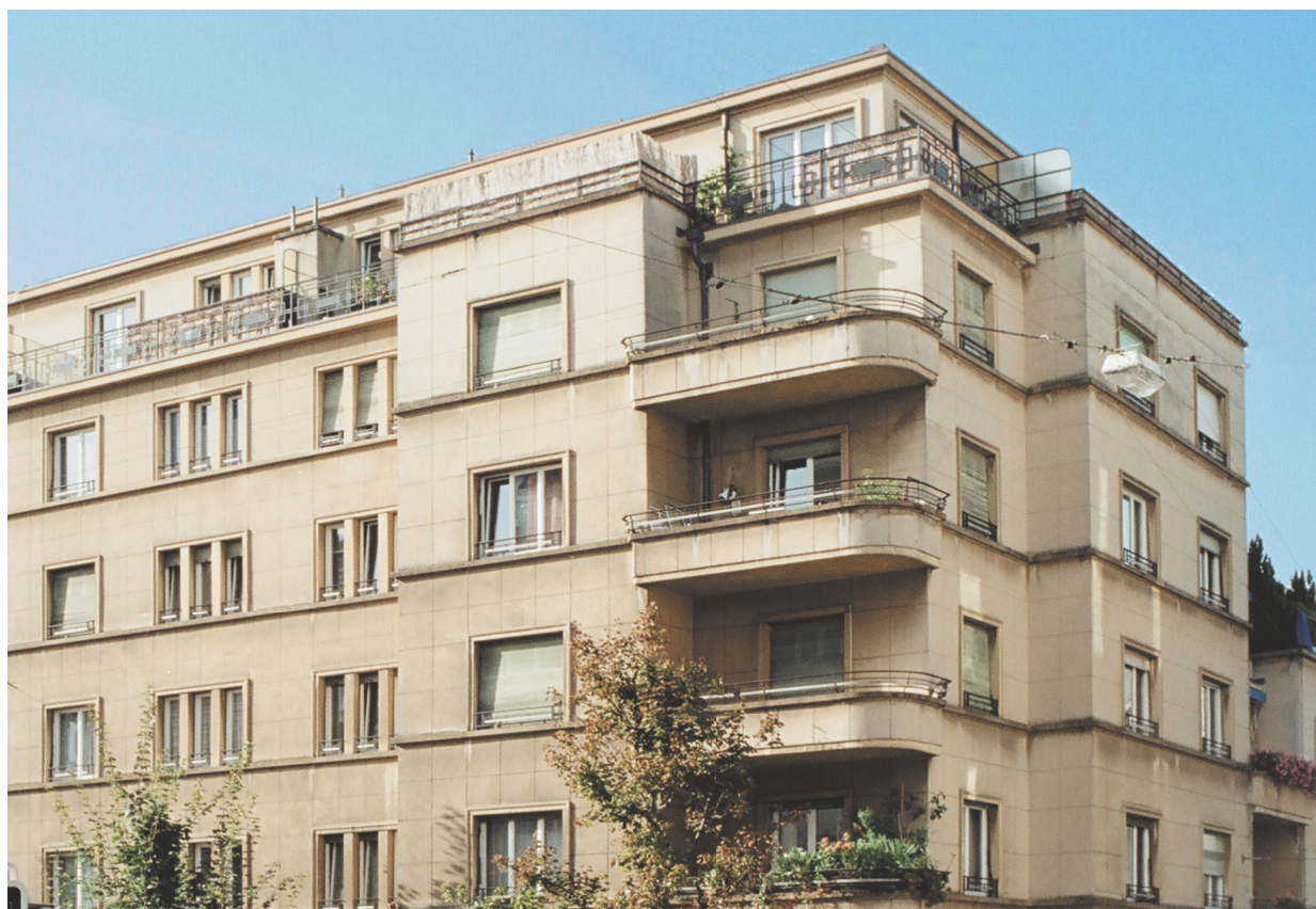
Nouvelle acquisition / Neue Akquisition: Rue de Langallerie 4, Lausanne
