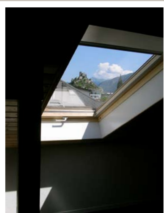
Transformation des combles de l'immeuble à la rue des Amandiers 13, Sion.
