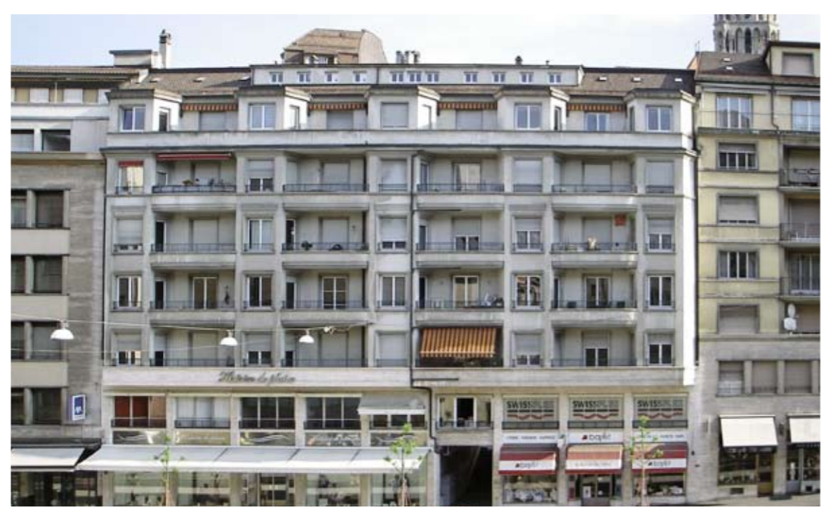
Rue Centrale 17-19, Lausanne
