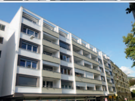
RÉNOVATIONS RENOVIERUNGEN Fbg du Lac 31, Neuchâtel / Neuenburg
