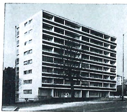
Avenue des Alpes 29 La Tour-de-Peilz
