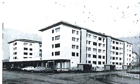
Rue St-Guérin 14-16-18, chemin du Vieux-Canal 35-37, Sion
