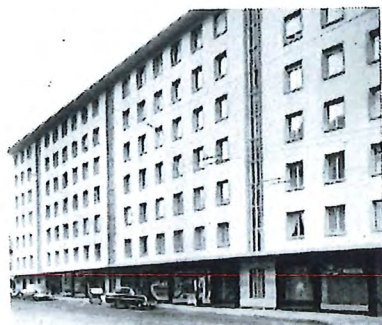
Rue de la Maladière 16, 18, 20 Neuchâtel
