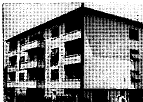
Rue du Cheminet 52 Yverdon
