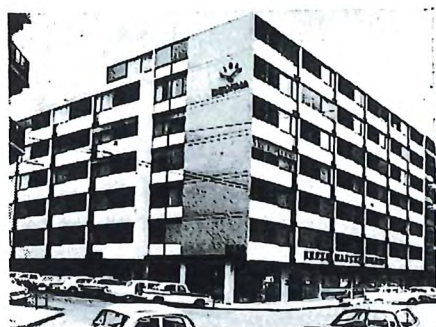
Rue des Pâquis 39-41, rue du Môle 2-4, Genève
