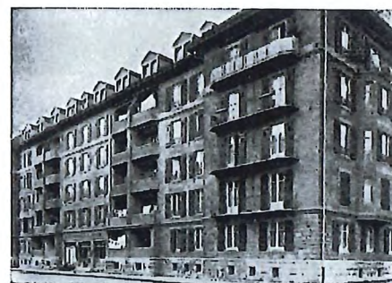
Rue de l'Eglise 2-4-6 Neuchâtel
