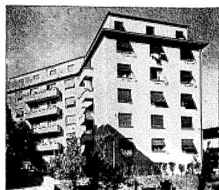
Rue de la Pontaise 25 Lausanne
