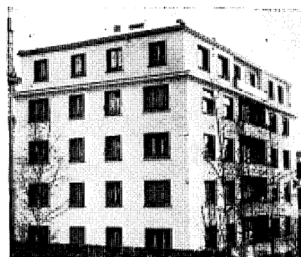
Rue de la Pontaise 21 Lausanne
