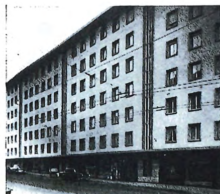
Rue de la Maladière 16-18-20 Neuchâtel
