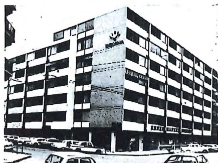
Rue des Pâquis 39-41, rue du Môle 2-4, Genève
