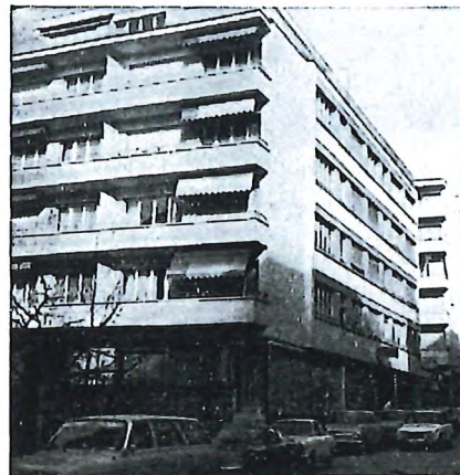
Chemin des Rosiers 4 Lausanne
