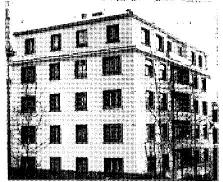
Rue de la Pontaise 21 Lausanne
