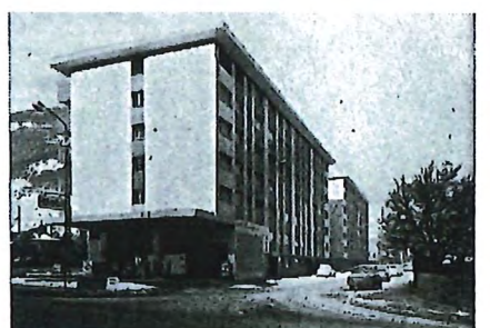
Avenue de la Moya 12-14 Martigny
