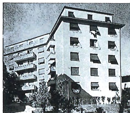
Rue de la Pontaise 25 Lausanne
