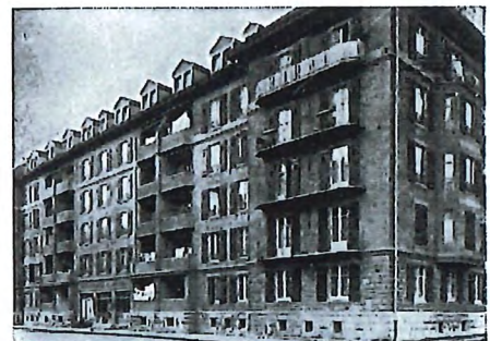
Rue de l'Eglise 2-4-6 Neuchâtel
