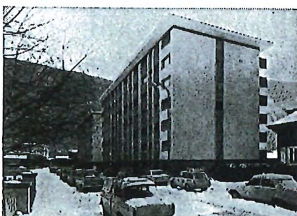
Avenue de la Moya 8-10 Martigny
