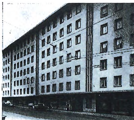
Rue de la Maladière 16-18-20 Neuchâtel
