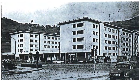
Rue St-Guérin 14-16-18, chemin du Vieux-Canal 35-37, Sion
