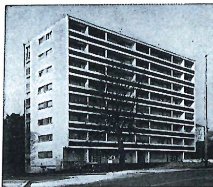
Avenue des Alpes 29 La Tour-de-Peilz
