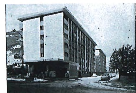
Avenue de la Moya 12-14 Martigny
