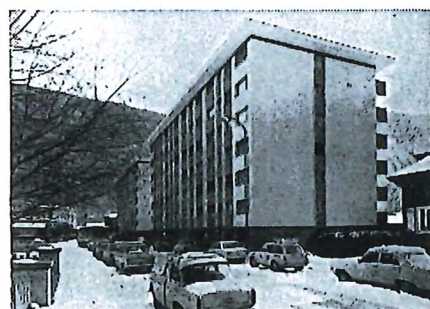
Avenue de la Moya 8-10 Martigny
