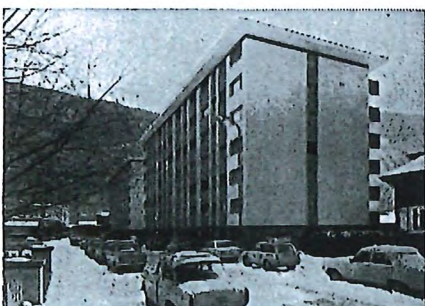
Avenue de la Moya 8-10 Martigny
