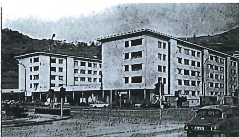
Rue St-Guérin 14-16-18, chemin du Vieux-Canal 35-37, Sion
