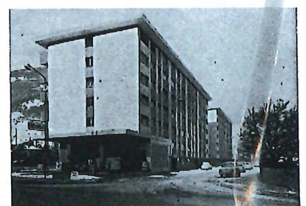
Avenue de la Moya 12-14 Martigny
