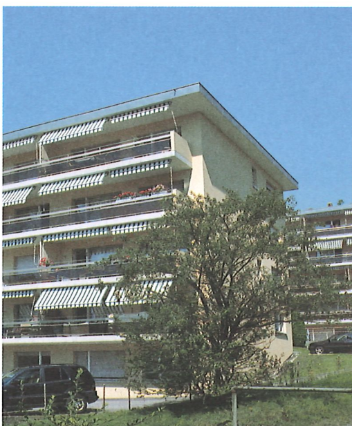
Pully, Avenue du Tirage 11 et 13
