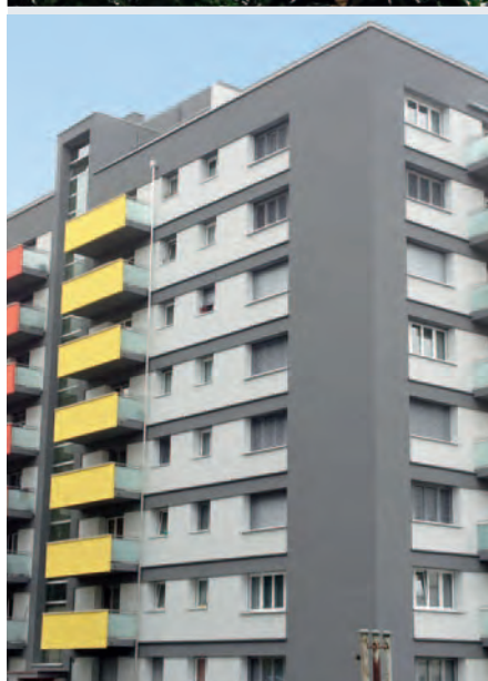
RÉNOVATIONS RENOVIERUNGEN Av. Gustave-Coindet 7-9, Vevey
